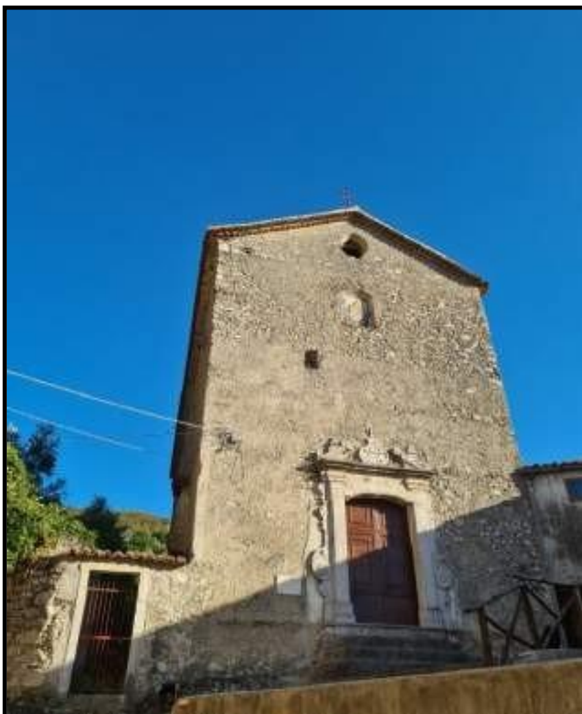
Figura 2 - La facciata chiesa di S. Pietro nella parte più alta del borgo
